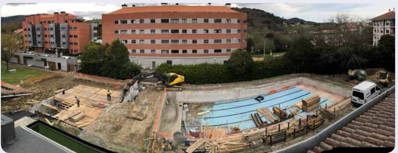
Ejecución de los vasos de las piscinas con hormigón armado, con empleo de aditivo impermeabilizante.
